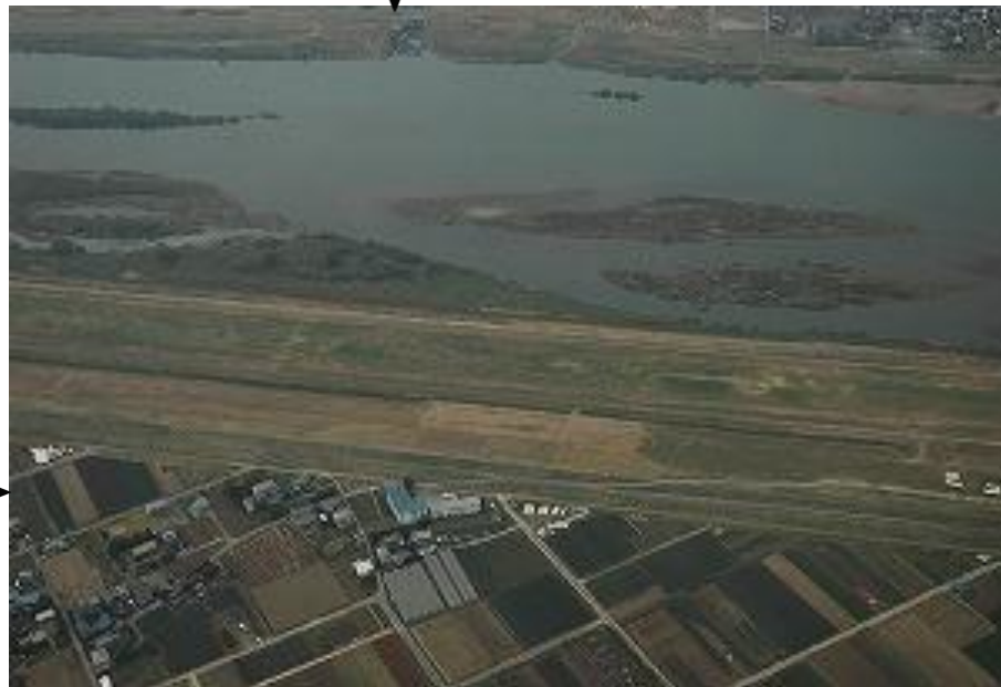
めぬま 妻沼訓練所の格納庫棟
