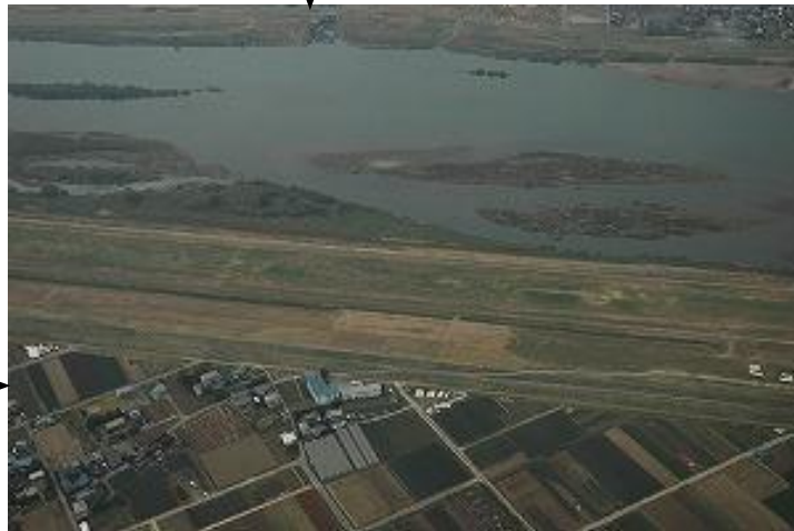
①めぬま 妻沼訓練所の格納庫棟
