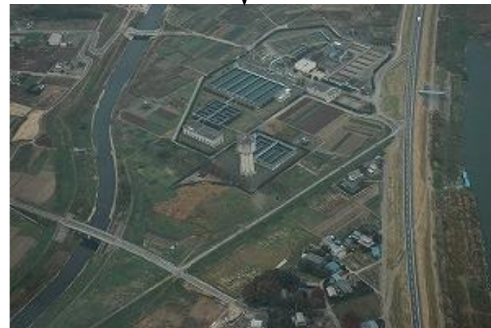
②高林給水塔 太田市高林の工業用給水塔 刀水橋の北西約 1km
