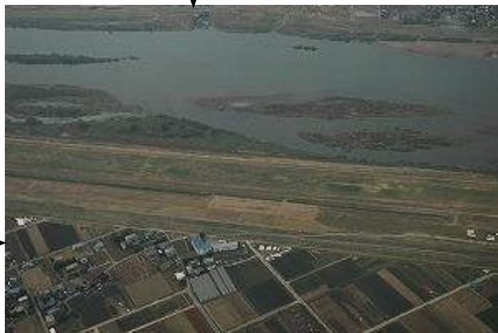
①めぬま 妻沼訓練所の格納庫棟
